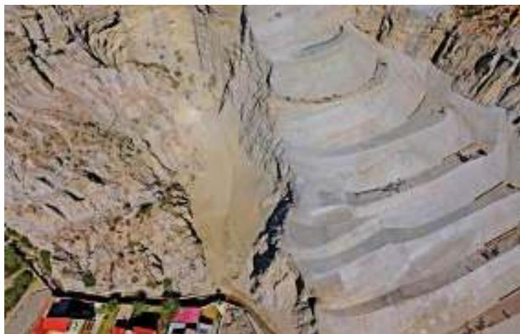
Fotografía N°34. Municipio de La Paz: Estabilización de área de deslizamiento;
