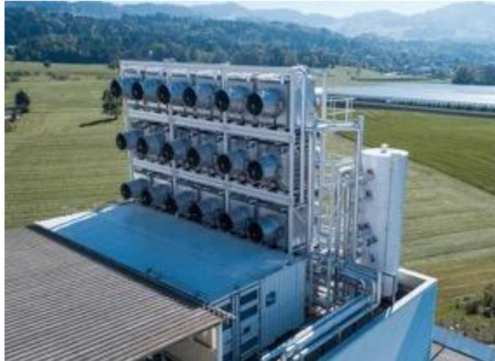
Imagen 13: maquina Climeworks para capturar CO<sub>2</sub> (Climeworks)
