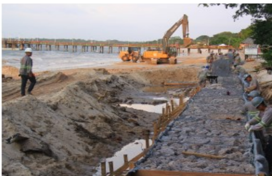
Construção do gabião da Praia do Caripi (Foto: ASCOM).
