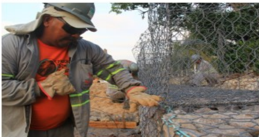
Construção do gabião da Praia do Caripi (Foto: ASCOM).
